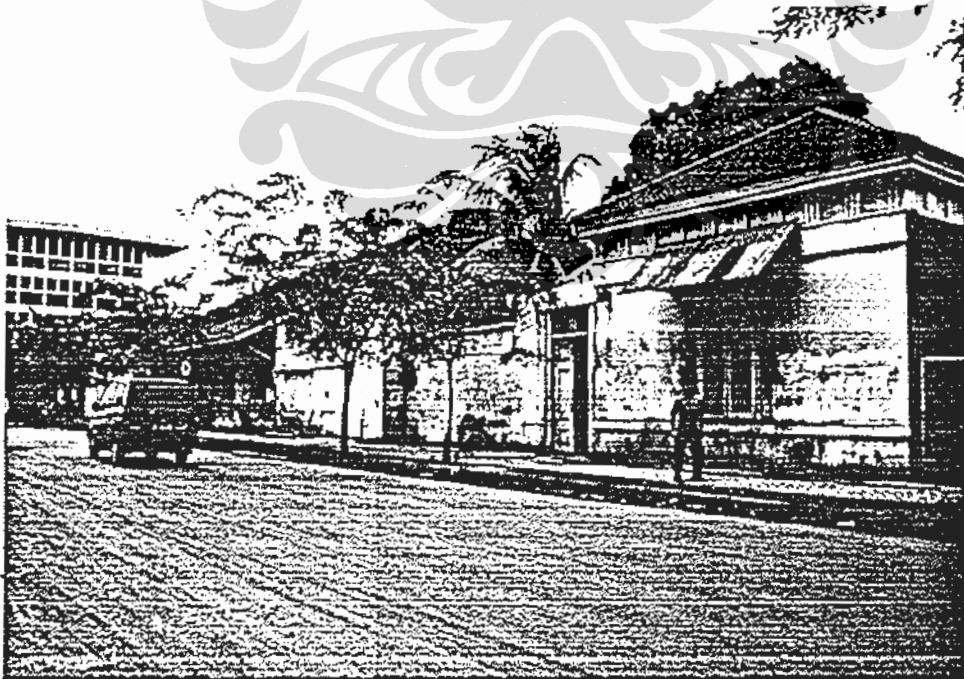
Foto 36. Bagian belakang sisi utara
